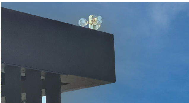
CAPTEUR VENT, PLUIE ET TEMPÉRATURE alimenté par la centrale de la pergola
